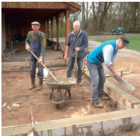
Herbert Bergmeier, Paul Grote und Eberhard Pelz waren maßgeblich an der Errichtung der Grillhütte beteiligt. (v.l.n.r.)
